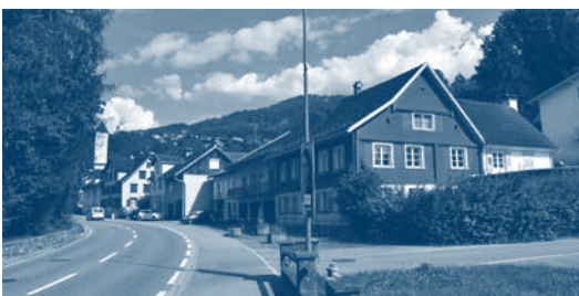
Der Grüne Baum kurz vor dem Abbruch – bereits 1988 hatte dieser traditionsreiche Gastbetrieb seine Tore für immer geschlossen.
